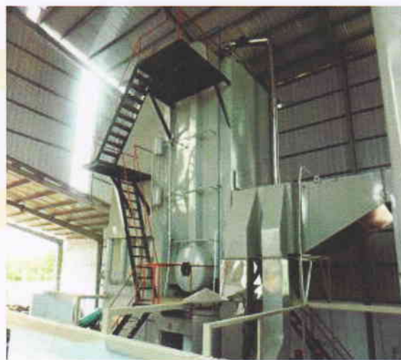
Dự án cấp nhiệt công suất: 15 tấn/giờ Công ty Cao Su Mai Vĩnh
